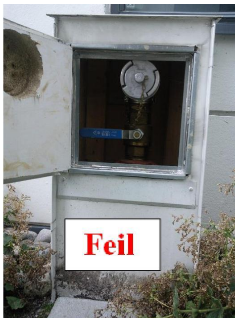
Figur 8 Koblinger må være innrettet slik at slanger kan kobles på uten å komme i konflikt med bygningskonstruksjoner eller lignende Rundt Ø 65 mm NOR Lås 1 koblinger må det være god plass for å kunne bruke koblingsnøkler
