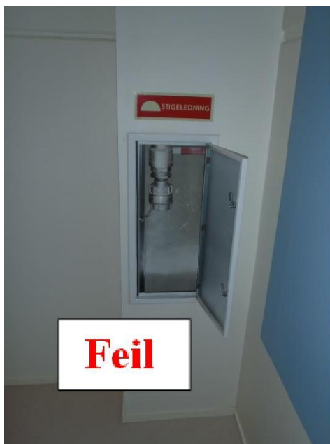
Figur 8 Koblinger må være innrettet slik at slanger kan kobles på uten å komme i konflikt med bygningskonstruksjoner eller lignende Rundt Ø 65 mm NOR Lås 1 koblinger må det være god plass for å kunne bruke koblingsnøkler
