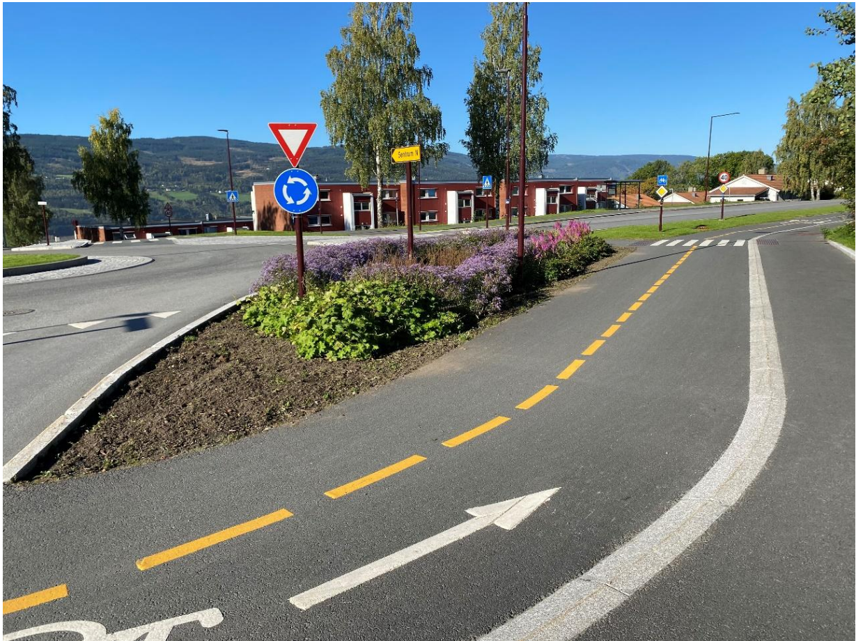
Bilde 2: Regnbed som del av lokal overvannsjåndtering i Sigrid Undsets veg
