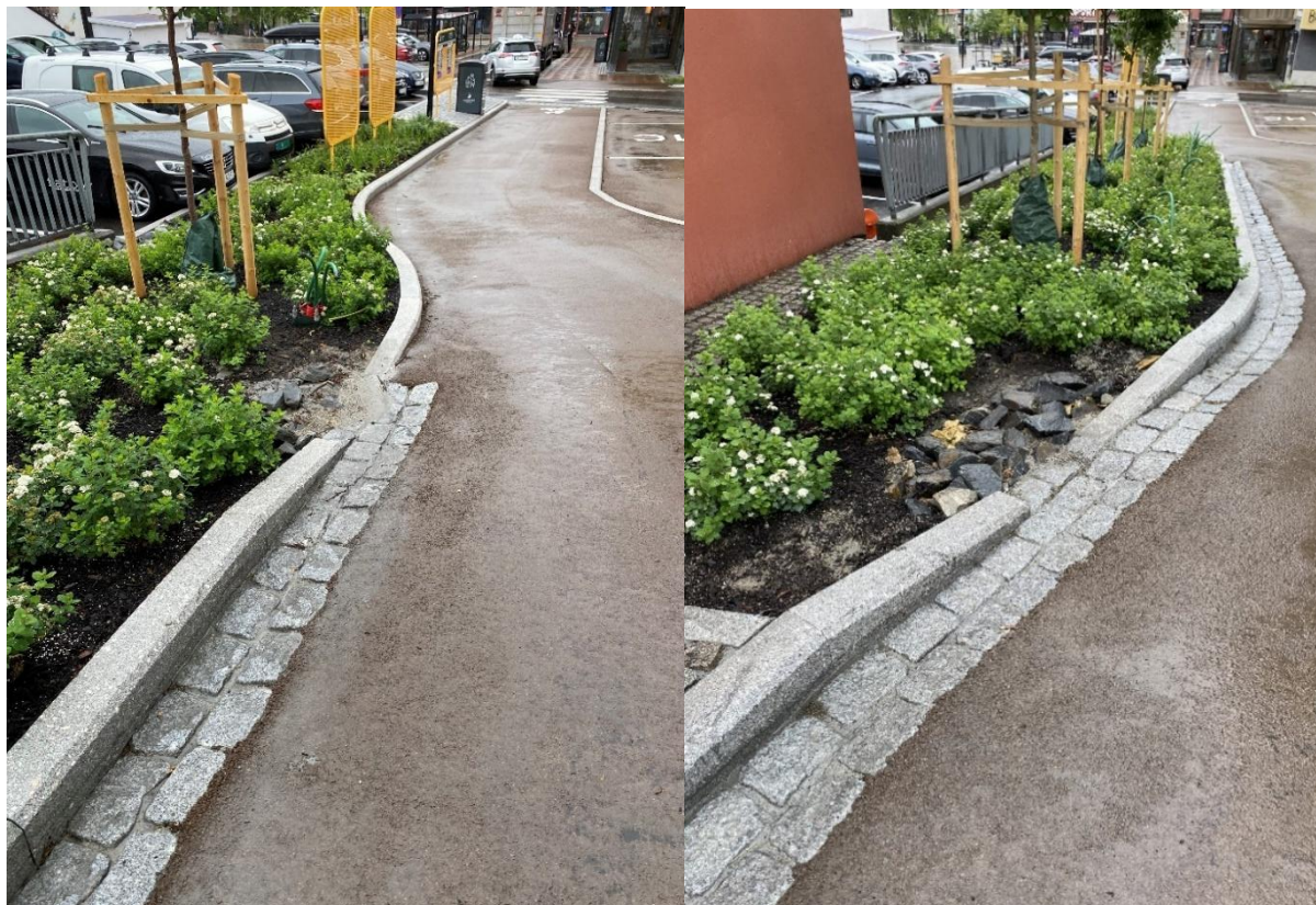
Bilde 3: Overvann ledes inn i plantefelt i Gamlevegen/Nordsetervegen
