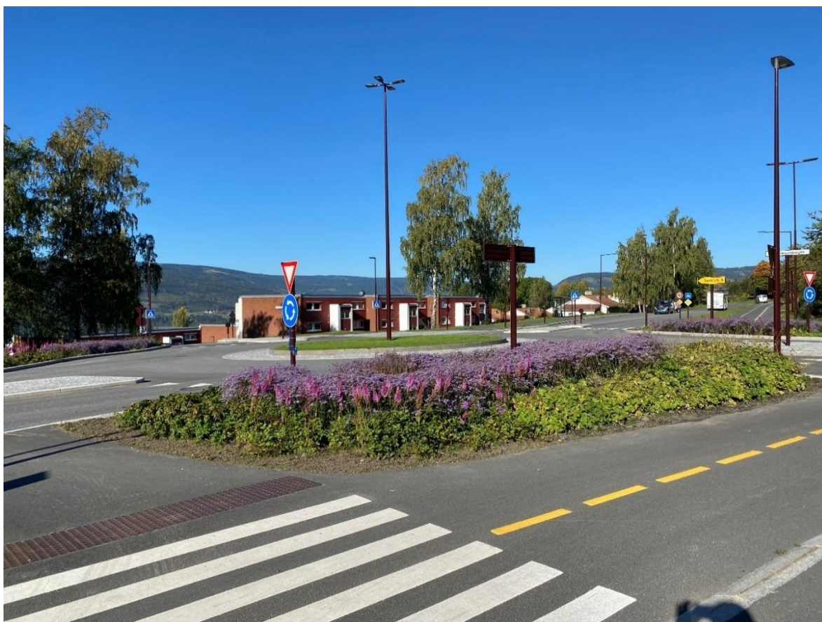
Bilde 1: Regnbed som del av lokal overvannsåndtering i Sigrid Undsets veg
