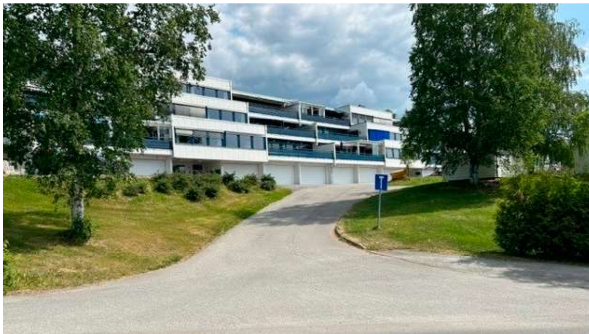
Figur 10: Adkomstvegen, Stabbursvegen, til planområdet, sett fra Hammersengvegen.
